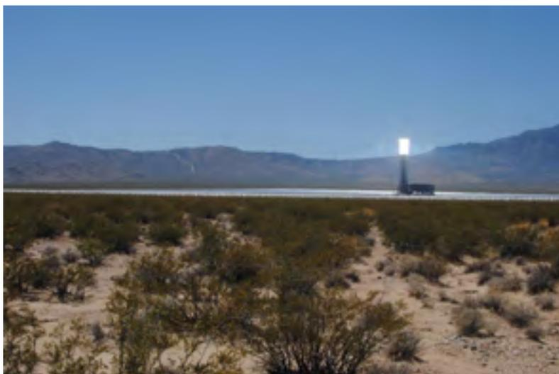
Как только пересекли границу штатов, сразу увидели мощную солнечную станцию. Станция построена на более продвинутом принципе аккумулирования солнечной энергии на специальном накопителе. Т.е. в центре башня, наверху которой огромный бак, его нагревает солнечная энергия, отраженная от множества зеркал. Температура доходит до 400 градусов Цельсия. А далее работает уже турбина, вырабатывая электрическую энергию. Станция состояла из 3 площадок. Выглядит это довольно эффектно.
